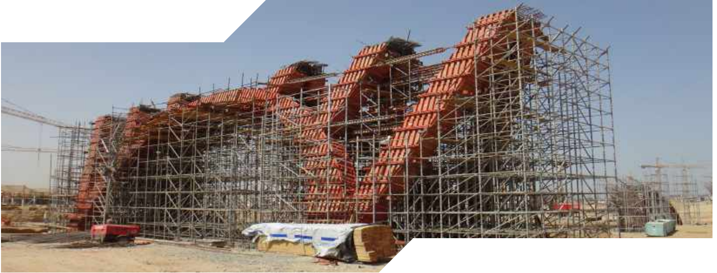
KAIA, Jeddah, KSA
